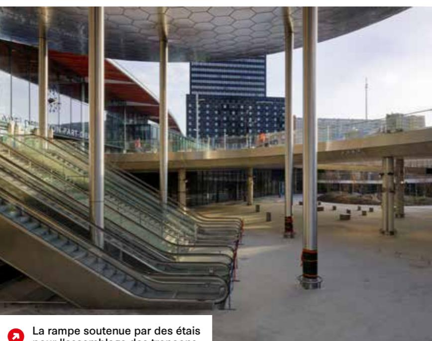
2 La rampe soutenue par des étai pour l'assemblage des tronçons.
