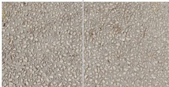
Le béton type «Garibaldi»
