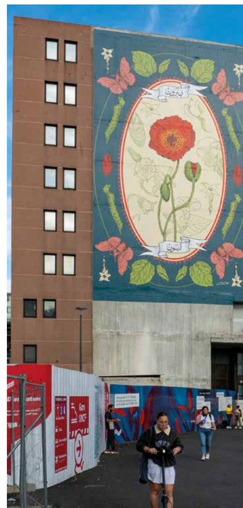
1 Montage de la charpente de la galerie Béraudier au niveau de To-Lyon. Les tours béton abriteront les futurs escaliers de secours.
