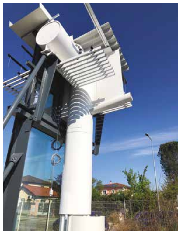
Construction du prototype de façade de la gare.
