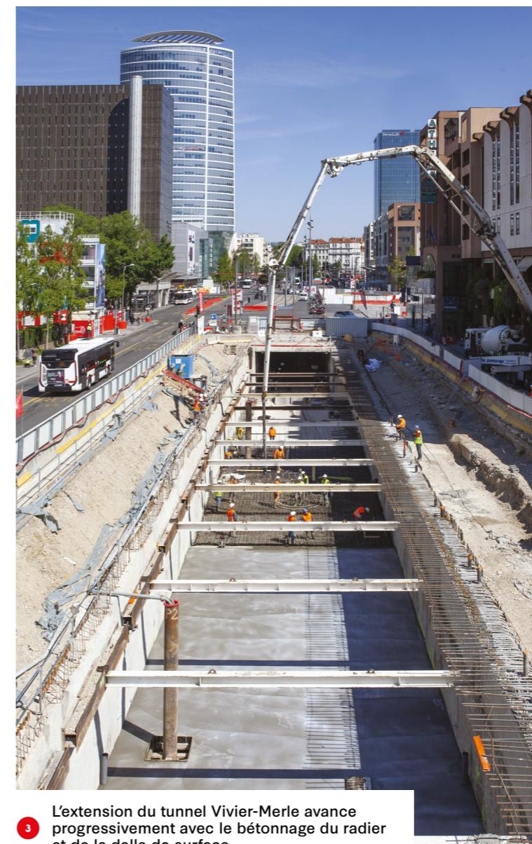
3 L'extension du tunnel Vivier-Merle avance progressivement avec le bétonnage du radier et de la dalle de surface.
