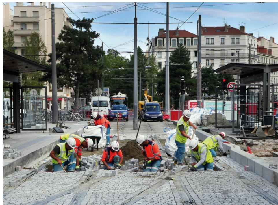
1 L'été a donné lieu à d'importants travaux sur les infrastructures du tramway T1. L'objectif : apporter plus de confort aux piétons et usagers des transports en commun en déplaçant le tiroir de retournement du tramway, jusqu'alors situé devant la gare, sur la rue Servient au pied de la tour Part-Dieu.
