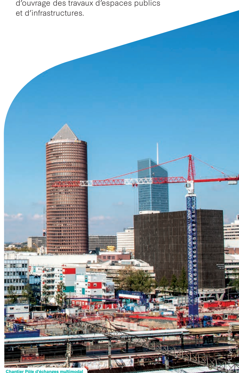
Chantier Pôle d'échanges multimodal
