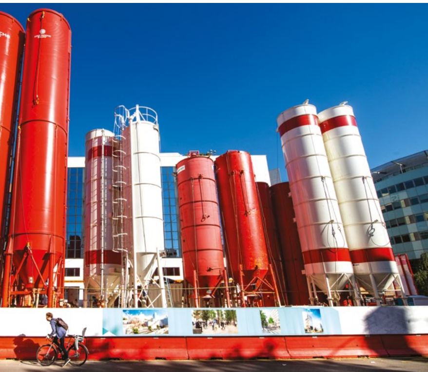
2 Les centrales à bentonite sont opérationnelles pour produire la boue nécessaire aux parois moulées du tunnel Vivier-Merle.
