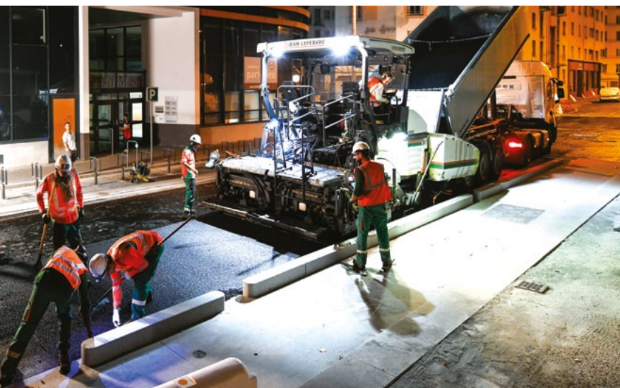
3 Rue Maurice Flandin, les travaux de la finalisation de la rue ont été réalisés entre 22h et 5h30 pour ne pas impacter la circulation en journée.
