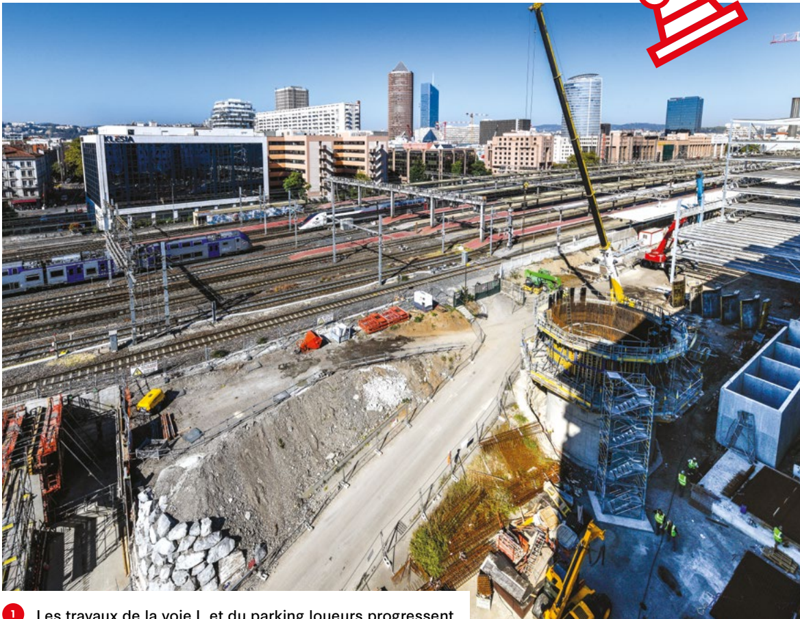
1 Les travaux de la voie L et du parking loueurs progressent.
