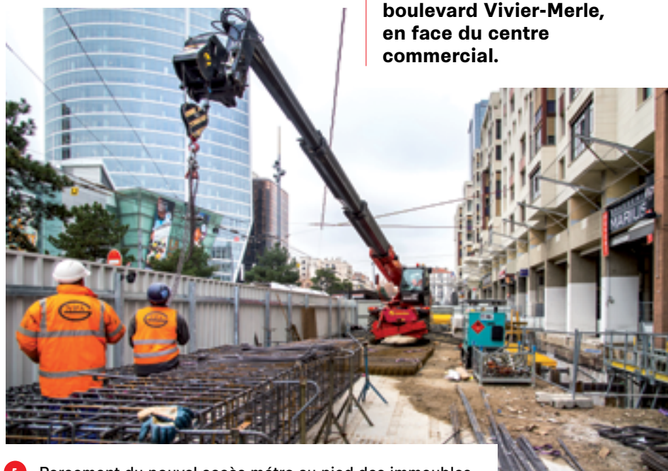
5 Percement du nouvel accès métro au pied des immeubles
