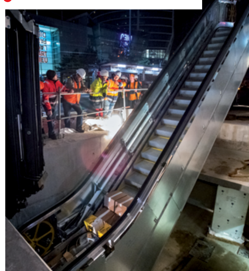
6 Installation nocturne de l'escalator du nouvel accès métro
