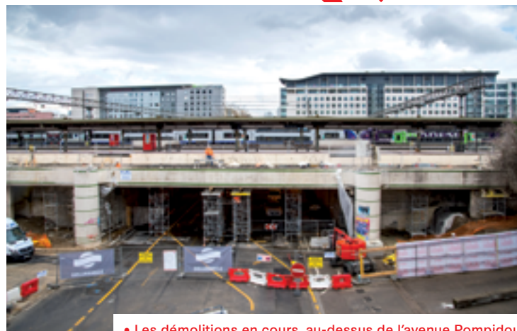
• Les démolitions en cours, au-dessus de l'avenue Pompidou
