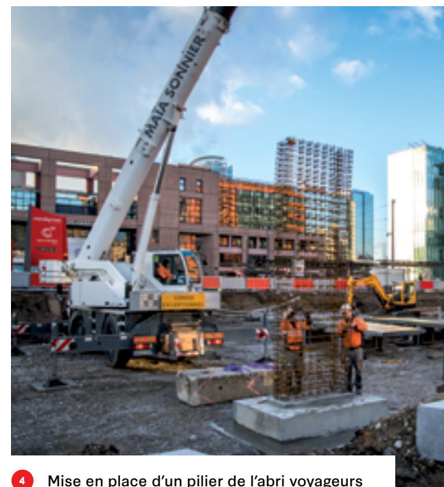
4 Mise en place d'un pilier de l'abri voyageurs
