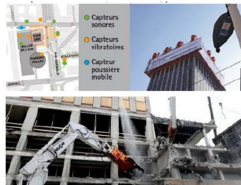
Figure 191 : Exemples de mesures mises en place dans le cadre du chantier de la Tour Incity : contrôle continu grâce à des capteurs (en haut), arrosage et micro-nébulisation pour limiter les poussières (en bas)
