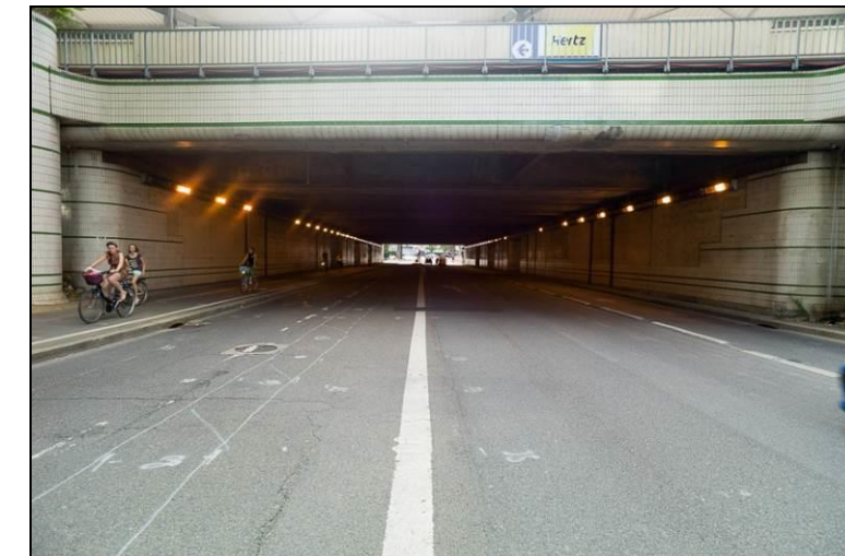
Figure 47 : Passage de l'avenue Pompidou sous les voies ferrées
