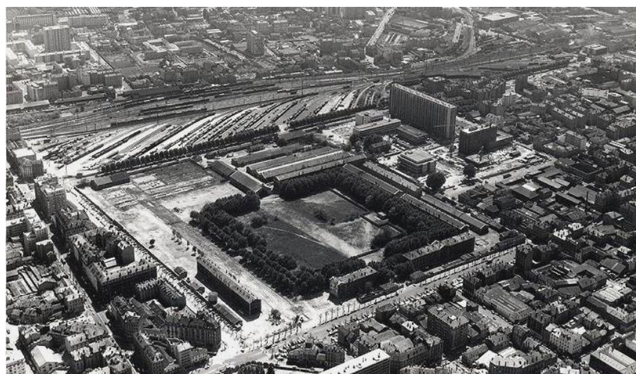
Figure 7 : Casernes de la Part-Dieu et emprise de la gare de marchandise au fond
