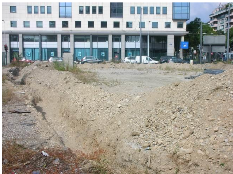
Figure 121 : Ancienne station-service – site BASOL, situé au Nord-Est du périmètre de projet (hors périmètre)
