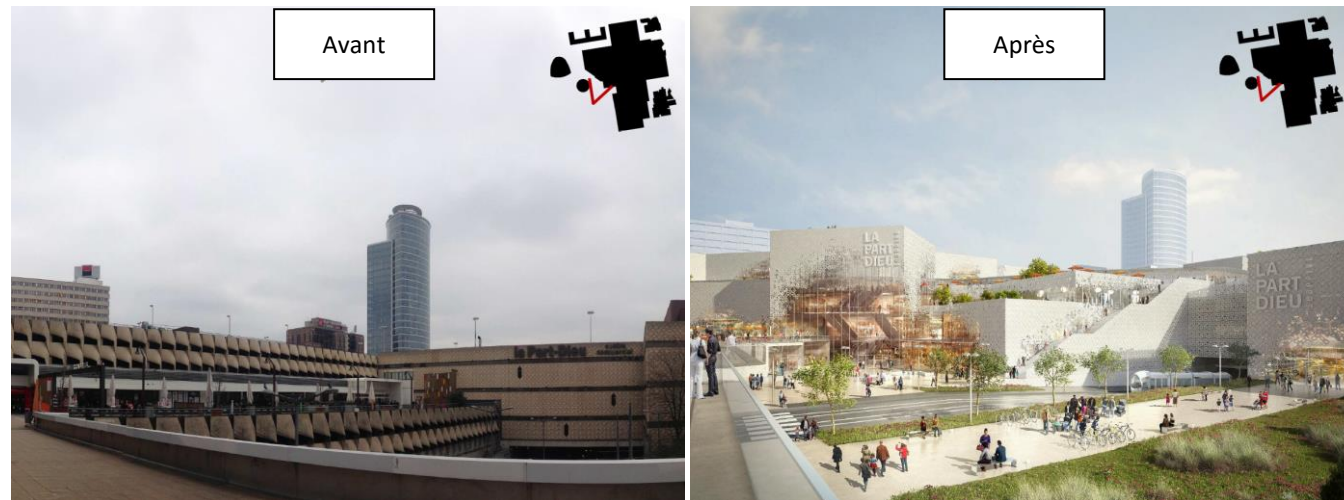
Figure 142 : Principes d'extension/restructuration du centre commercial, vue d'intention sur la nouvelle entrée rue Servient (source : Unibail Rodamco, mai 2016)
